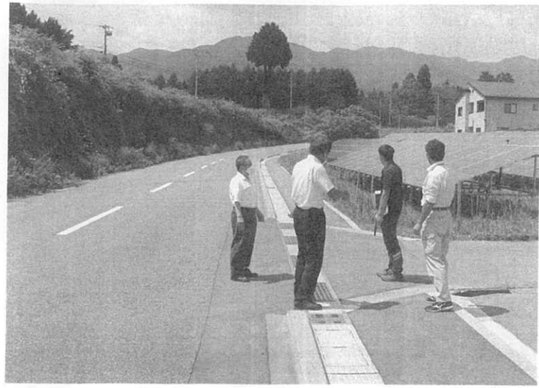
工事監査現地視察（村道5号線歩道新設工事）
