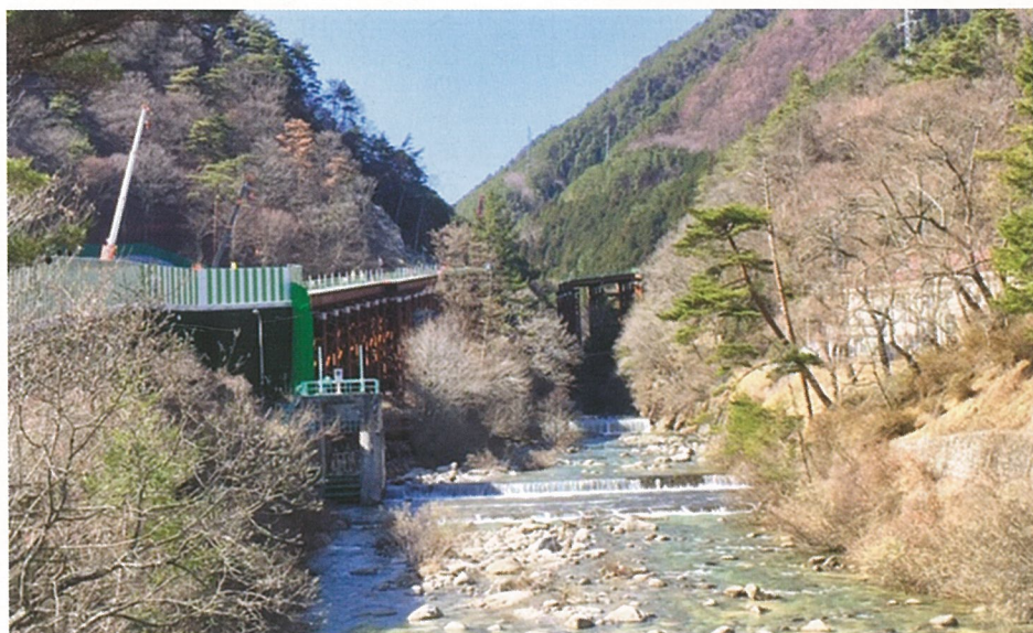
松川工区の仮栈橋
