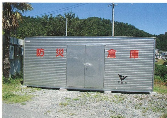
小学校駐車場設置
