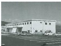
完成した工場
