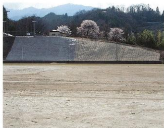
▲ 3月下旬 村民グランド西側法面を種子付ネット及び種子付ムシロ張により整備しました。
