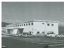
完成した工場
