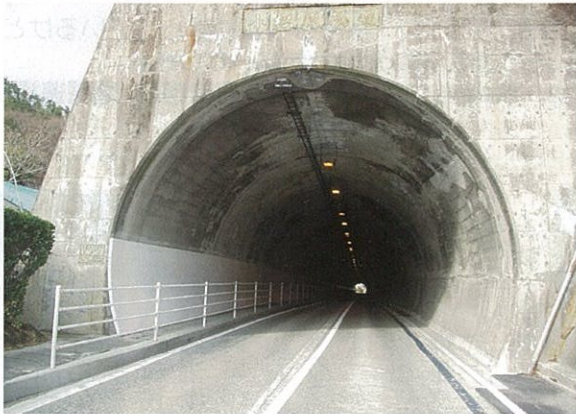
▲ 国道151号線小松原トンネルの歩道(L=298m)が、県の交通安全対策(歩道改修)によって、4~11月にかけて、側面塗装工事と歩道拡幅工事を施工して、安全にトンネル内を通行できるようになりました。
