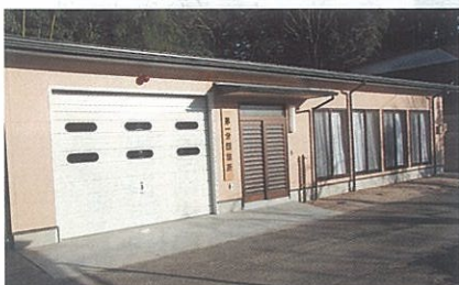
◀11月25日 第一分団詰所が旧詰所の隣に建設されました。地域防災施設の拠点として有効利用されるよう期待します。
