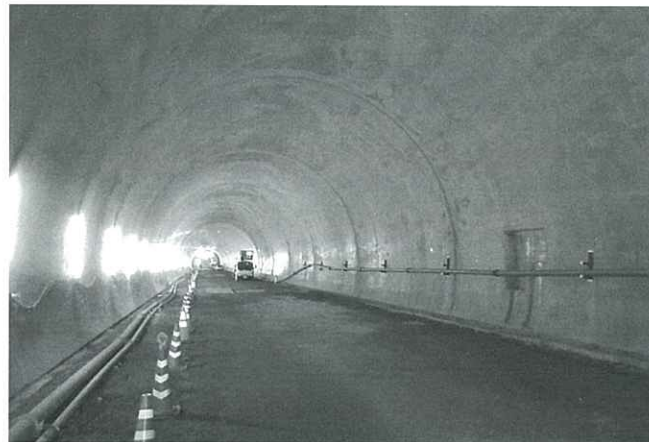
坑内覆工写真
