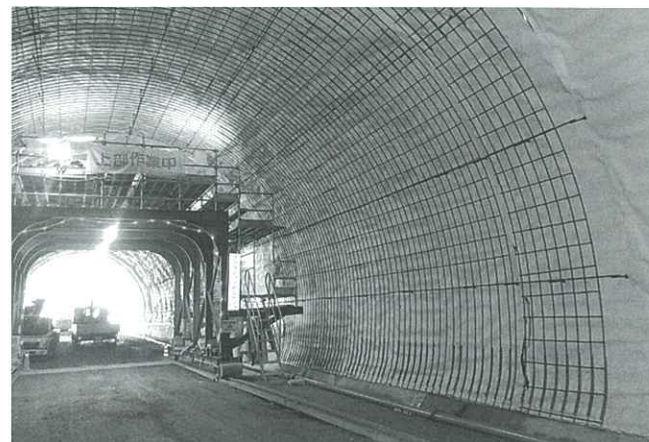
坑内防水工写真(終点側)
