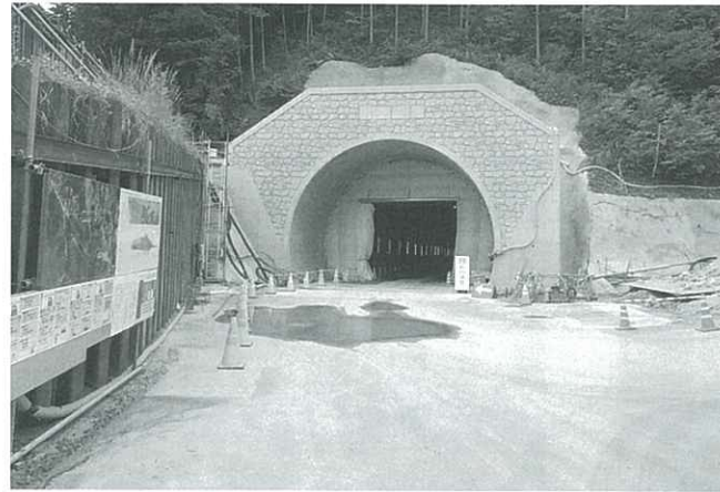
粒良脇側トンネル起点部
