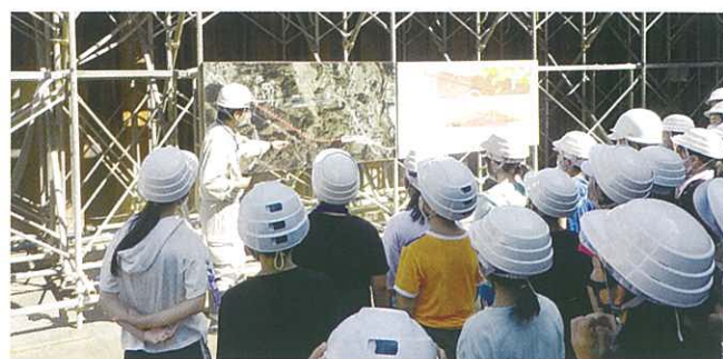
▲8月26日に小学1年生が、30日は小学6年生がそれぞれ粒良脇トンネルの工事現場の視察を行いました。
