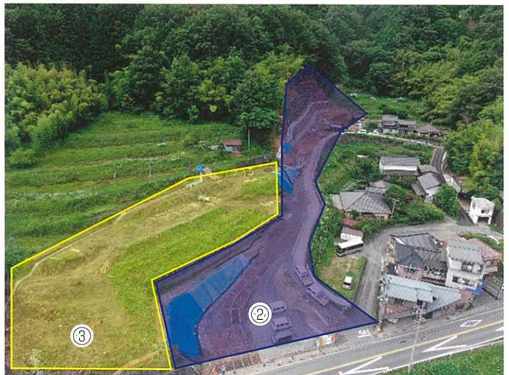
山田河内側トンネル終点部 写真
